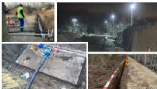
Foto: Construcție rețea apă spital militar ROL2, Apa Nova București
